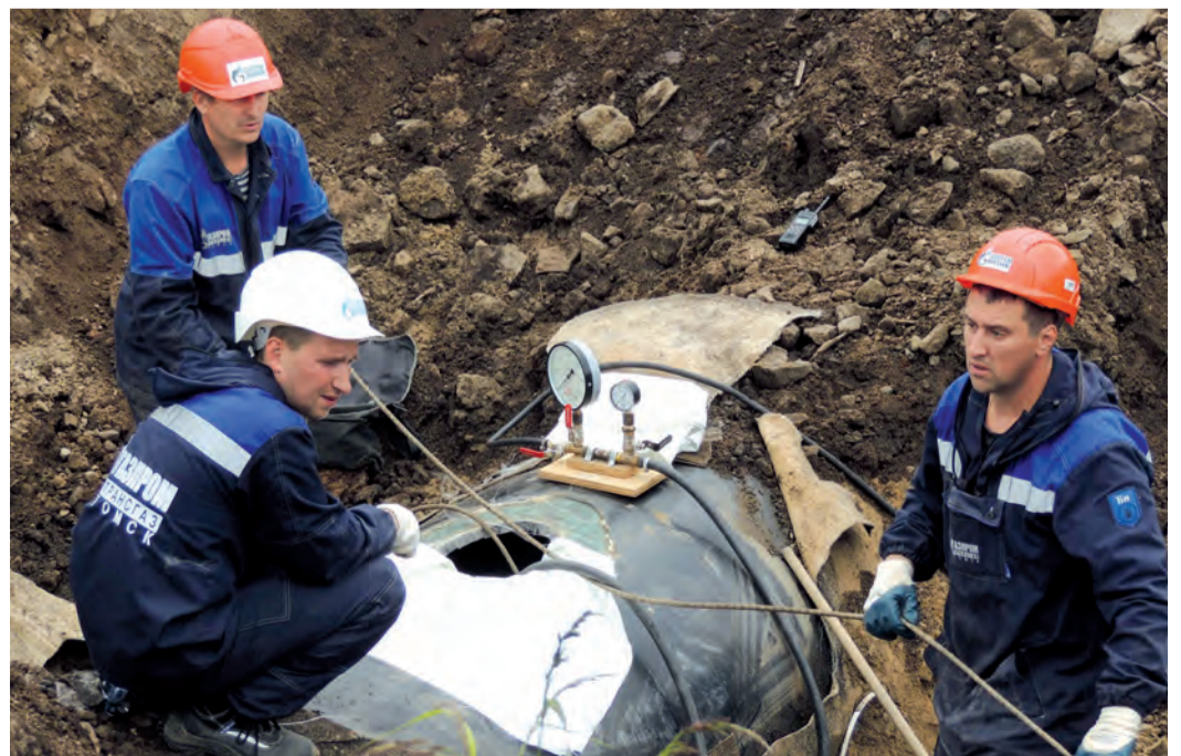
Самые масштабные ремонтные работы сотрудники Амурского ЛПУМГ провели в 2015 году: они устранили дефекты, выявленные по результатам внутритрубной диагностики, на участке протяженностью 144 км
