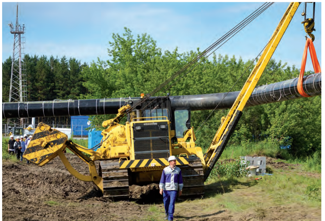
Доставить трубу к месту установки – непростая задача
