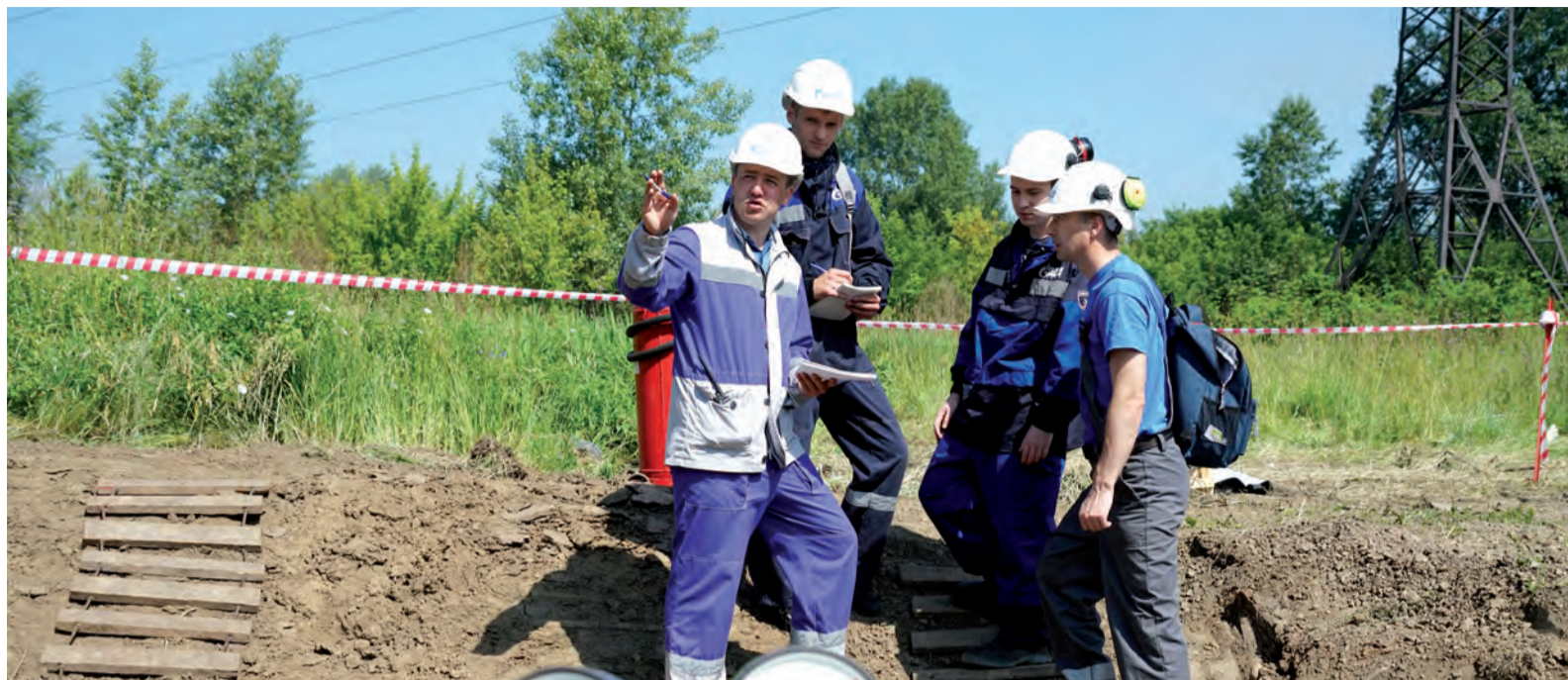
Сотрудники Алданского ЛПУМГ на огневых работах в Новокузнецке
