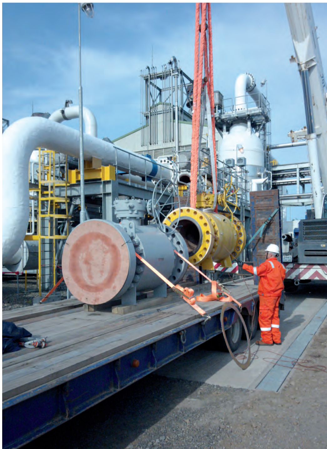
Процесс замены 30-дюймового крана на входе в газоперекачивающий агрегат насосно-компрессорной станции
