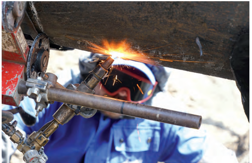
Автоматический аппарат для сварки трубы сам сделает ровный надрез, но это не значит, что его не нужно контролировать
