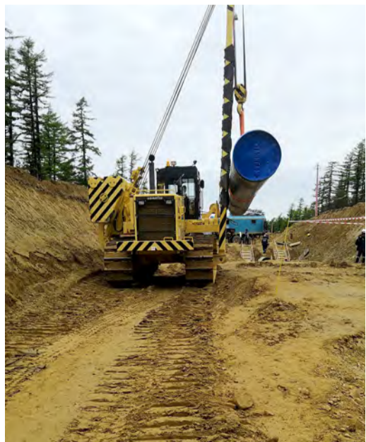
Сотрудники Сахалинского ЛПУМГ устанавливают на 48-м км газопровода БТК «Кириновское» – ГКС «Сахалин» трубу, доставленную из Томской области
